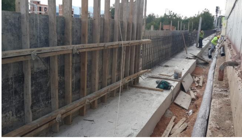
Tesis çevre duvar inşaatı
