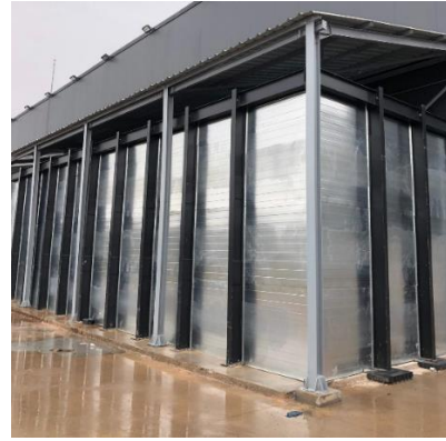
Sismik güçlendirme öncesi ve sonrası yangın su tankları
