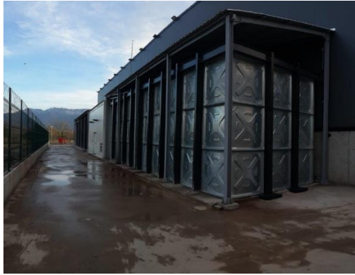
Sismik güçlendirme öncesi ve sonrası yangın su tankları
